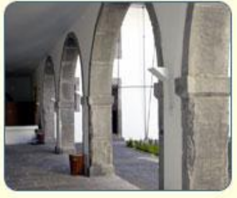
Os Arcos do Edifício da Reitoria
